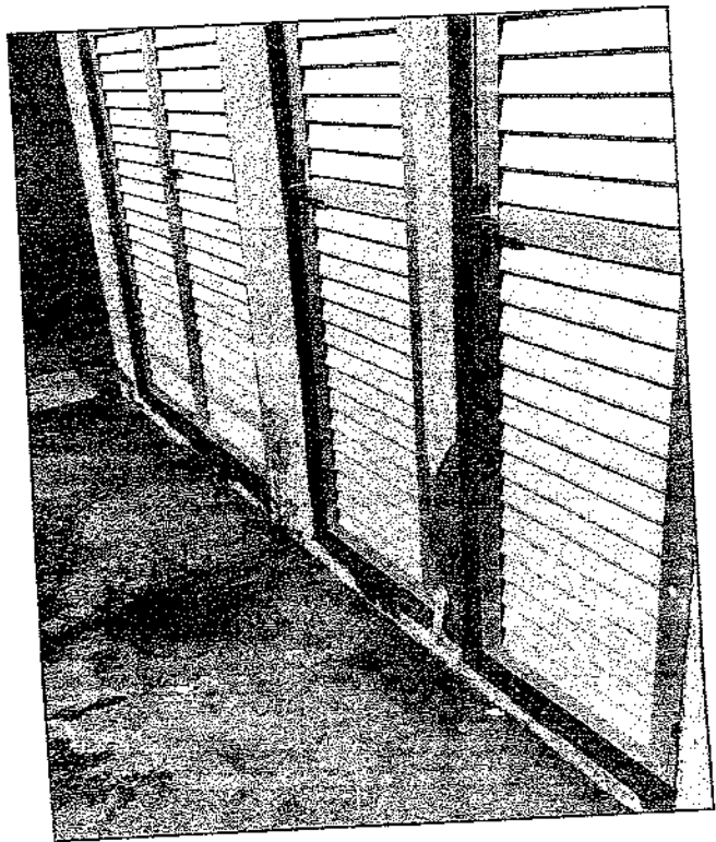
ÁREA EXTERNA DA EDIFICAÇÃO – DATA 15 DE JANEIRO DE 2020
